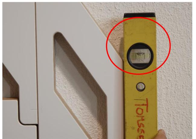
Mit einer Wasserwaage lässt sich die Treppe feinjustieren. Die Wasserwaage ist stirnseitig am Antritt der äußeren Wange anzulegen.
