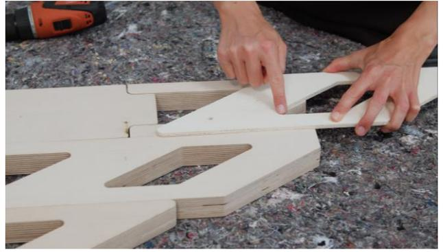
Achten Sie beim Platzieren der Distanzstücke darauf, dass die Ausfräsungen der Distanzstücke mit denen der Wange übereinstimmen.
