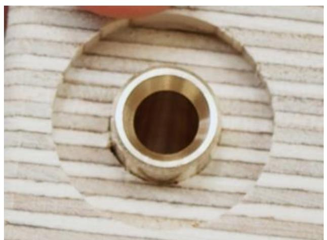
**ULTRALIGHT:** Die Buchse muss bündig eingeschlagen werden, sodass sie mittig im Bohrloch sitzt.
